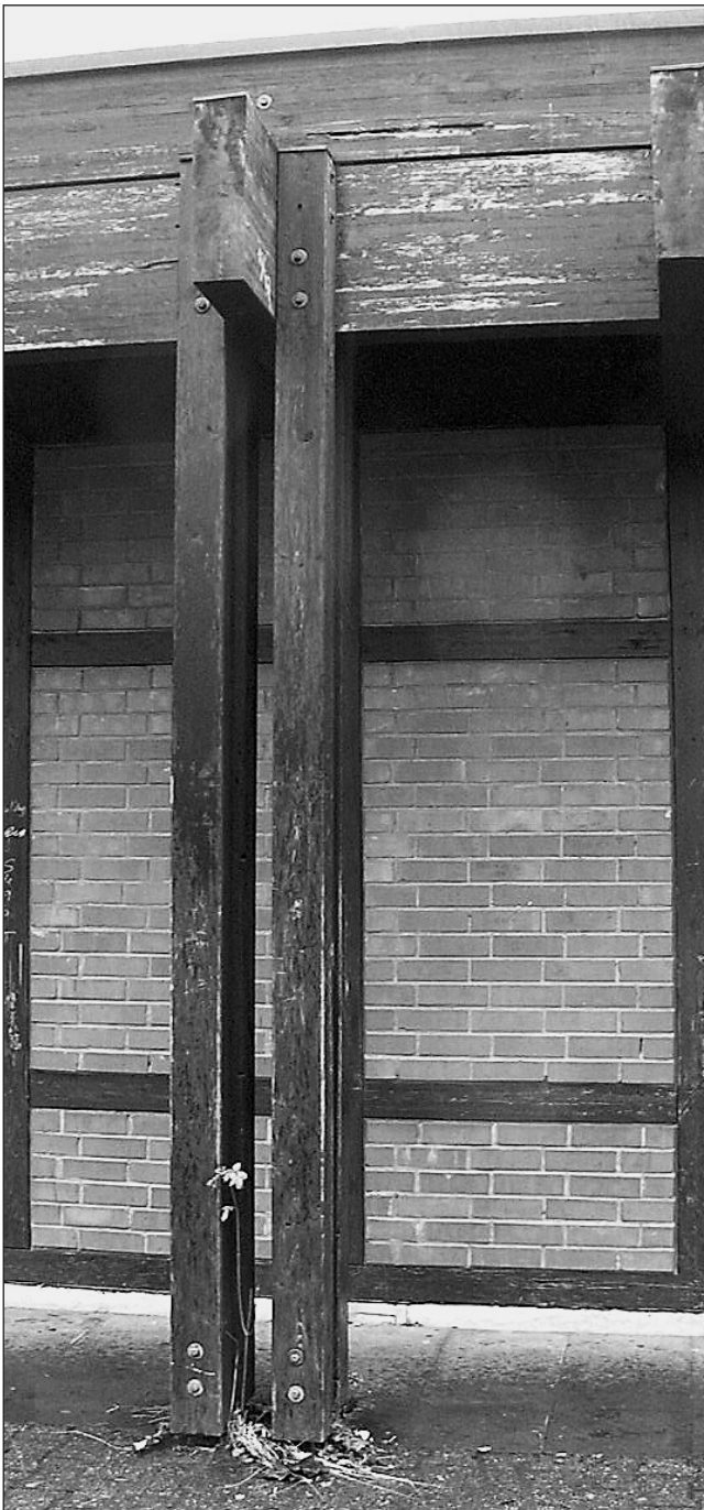
Abb. 1: Frei bewitterte Stützenkonstruktion
