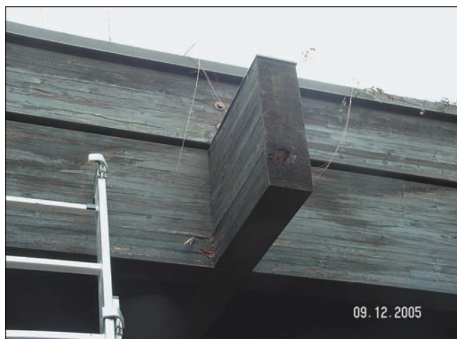
Abb. 2: Balkenkopf mit Fäulnis
