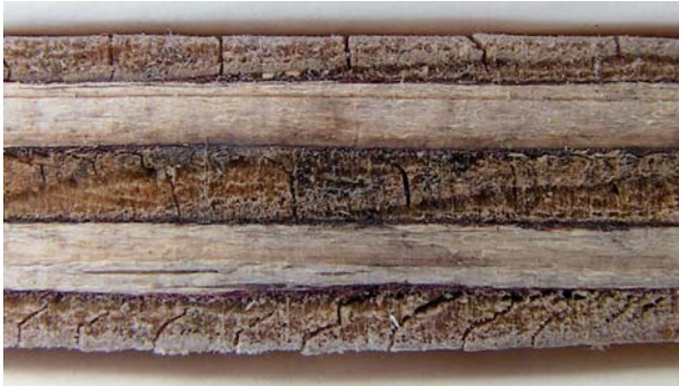
Bild 4: Schälrisse in der Seitenansicht
