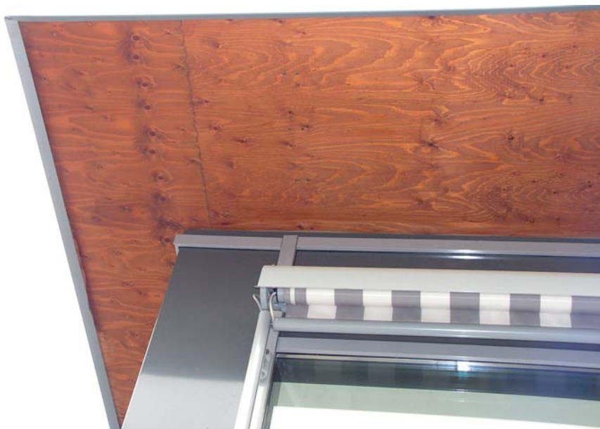
Bild 6: Freitragender Dachüberstand mit oberseitiger Dämmung
