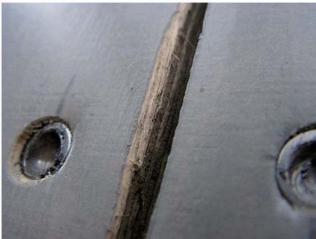
Bild 5: Schnittkante einer Fassadenplatte ohne Versiegelung
