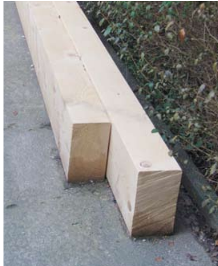
◀ Abbildung 6: So besser nicht: Konstruktionsvollholz (KHV) wird ohne Feuchteschutz an der Baustelle gelagert
