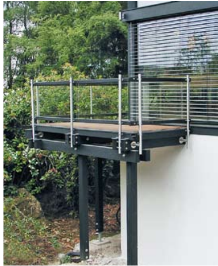
► Abbildung 4: Balkonanlage mit Stütze (GK 3.1) und Belag (3.2)
